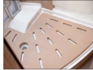
Holzboden in der Dusche
