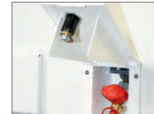
Gasanschluss aussen
